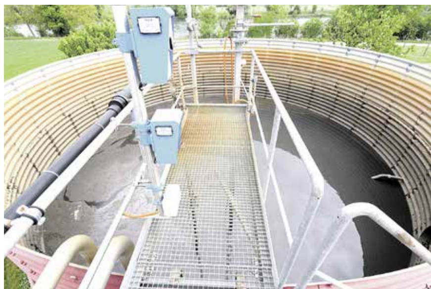
Der ausgefautte Schlamm wird in Zuzach zum Teil zwischengelagert, unter anderem im Schlammstapel-Becken.
