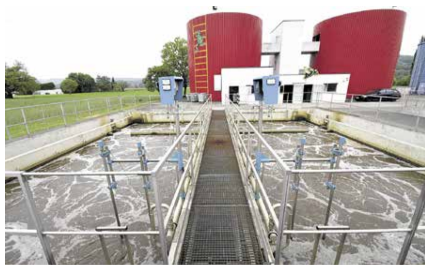
Mithilfe von Milliarden von Bakterien und Luftbläschen werden im Belüftungsbecken Verunreinigungen im Wasser abgebaut.
