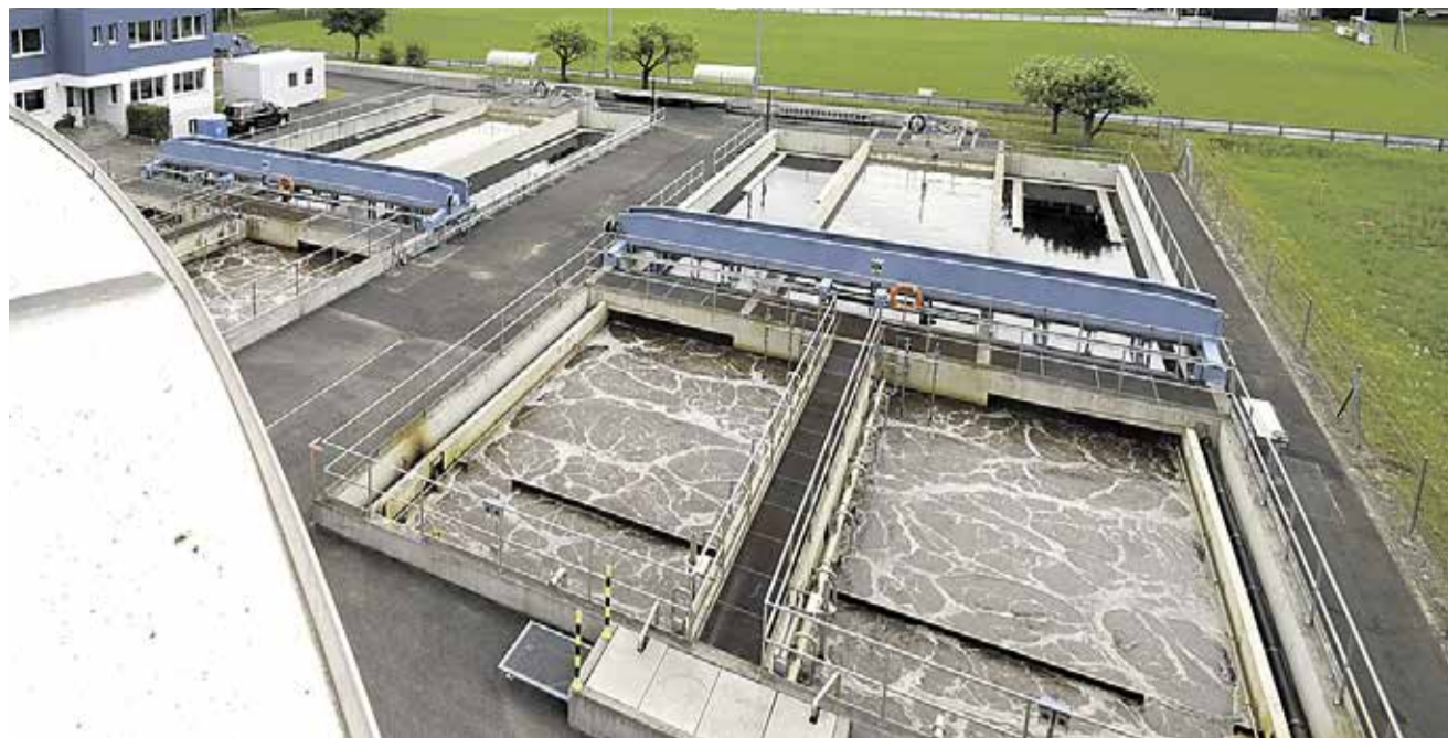
Vom Dach von Faulturm 1: Blick über die Kläranlage der ARA Region Zuzach.
