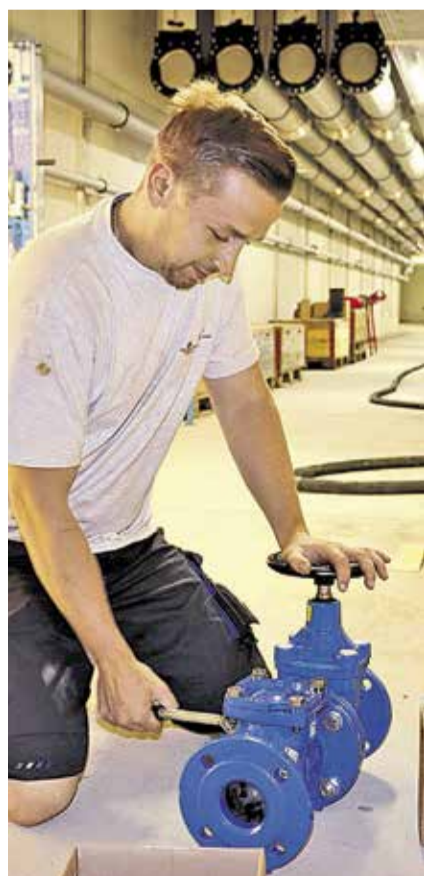
Im Untergrund des Neubaus werden Pumpen installiert.
