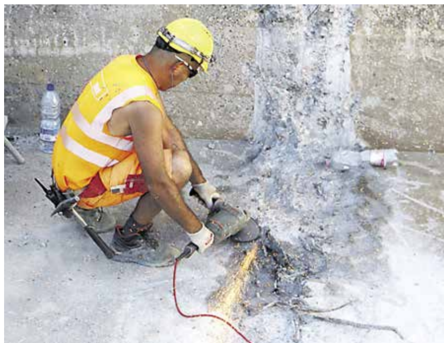
Ein Arbeiter entfernt die Reste einer Mauer im alten Klärbecken.
