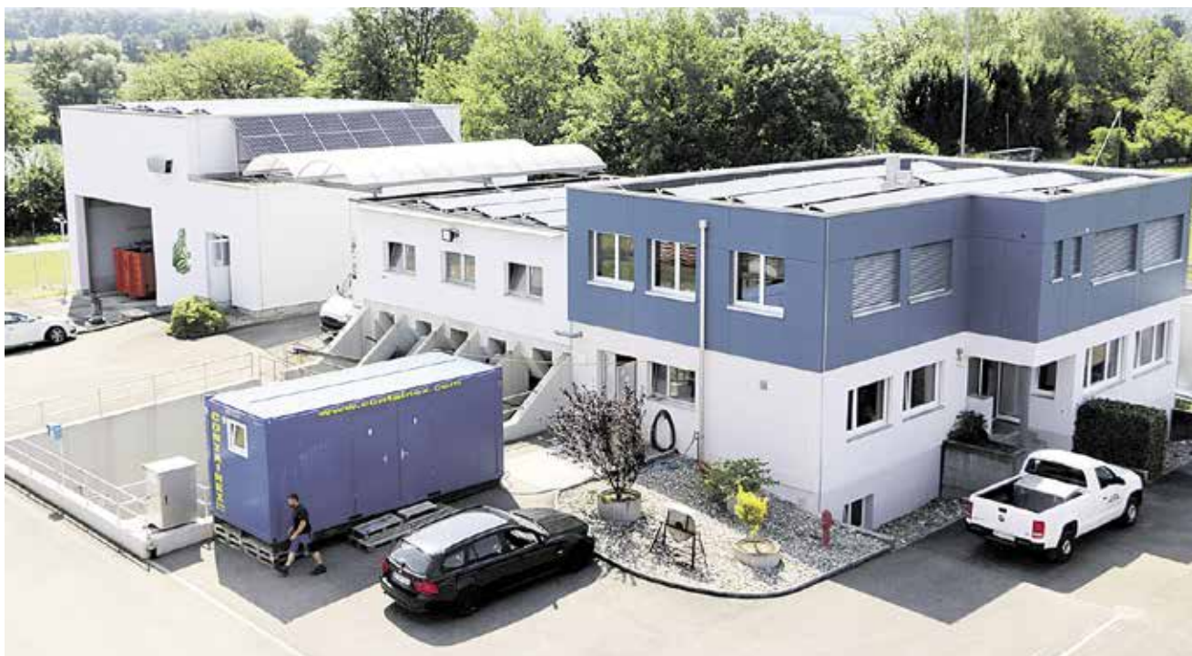
Das ARA-Betriebsgebäude mit der Aufstockung rechts in Blau und Solaranlage auf dem Dach. Links das Garderoben-Provisorium.
